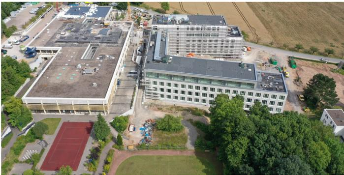
Mittlerweile ist der Rückbau des Bettenturms komplett abgeschlossen und die Sanierungsarbeiten im Inneren des Bestandsgebäudes sind bereits weit vorangekommen. Auch die Funktionsabteilung sowie die Physio- und Sporttherapie nehmen Gestalt an. Die neue Küche und das Restaurant sind ebenfalls auf dem besten Weg, genau wie der Ärztebereich.
